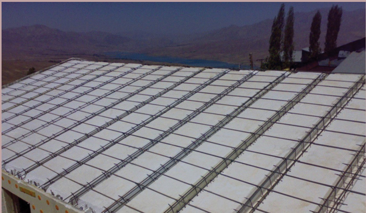
اجرای پانل سقفی سوپر پانل در سقف شیبدار ( مرحله قبل از تکمیل میلگردهای حرارتی )
