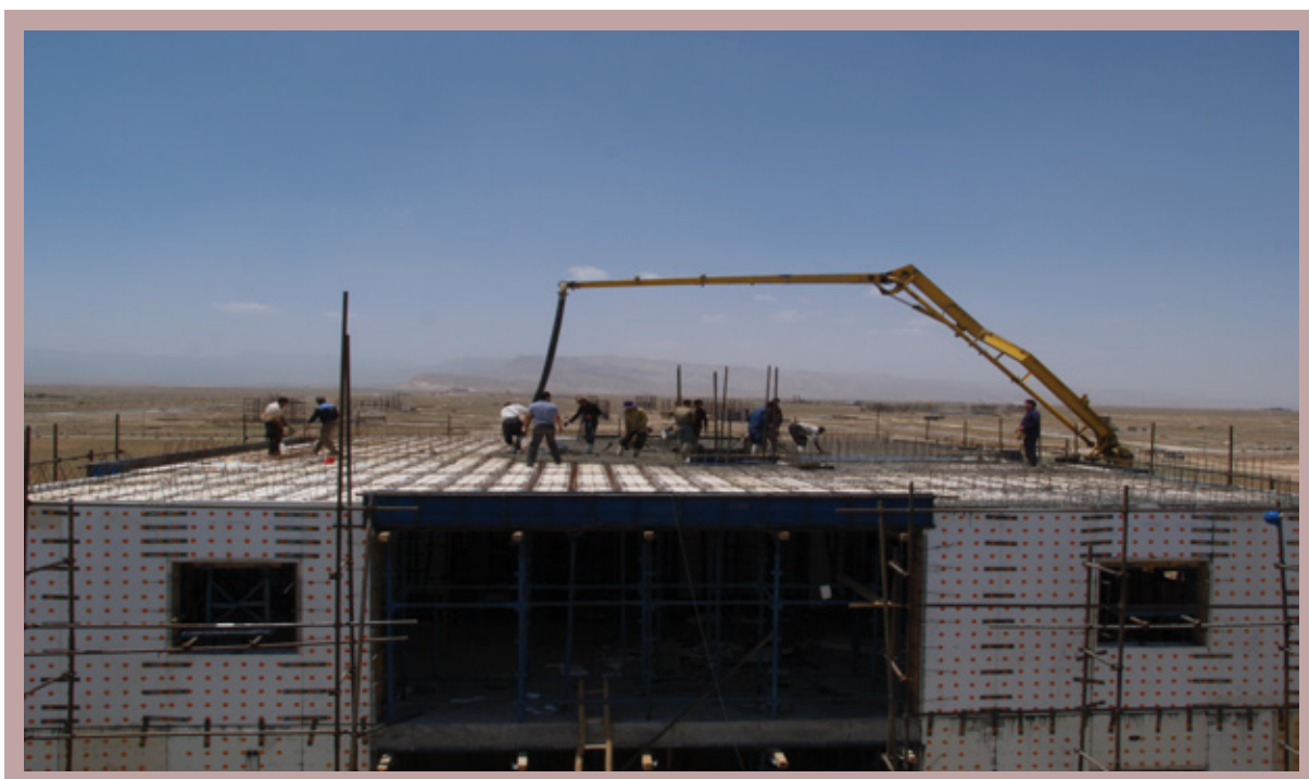
نحوه بتن ریزی سقفها و دیوارها بطور همزمان
