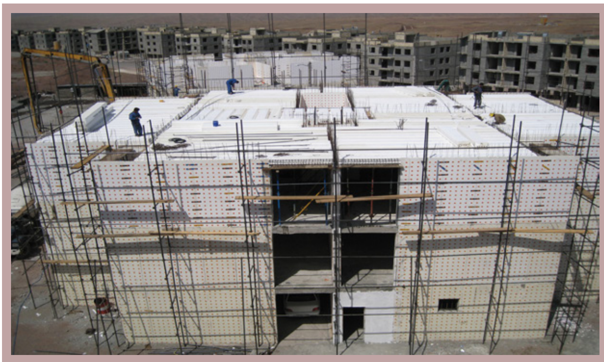
نحوه اجرای بلوک های سقفی
