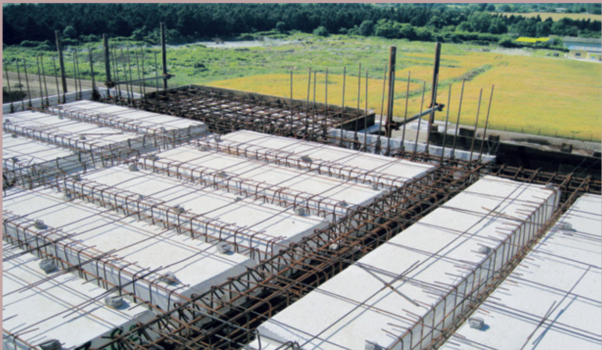
نحوه اجرای بلوک های سقفی
