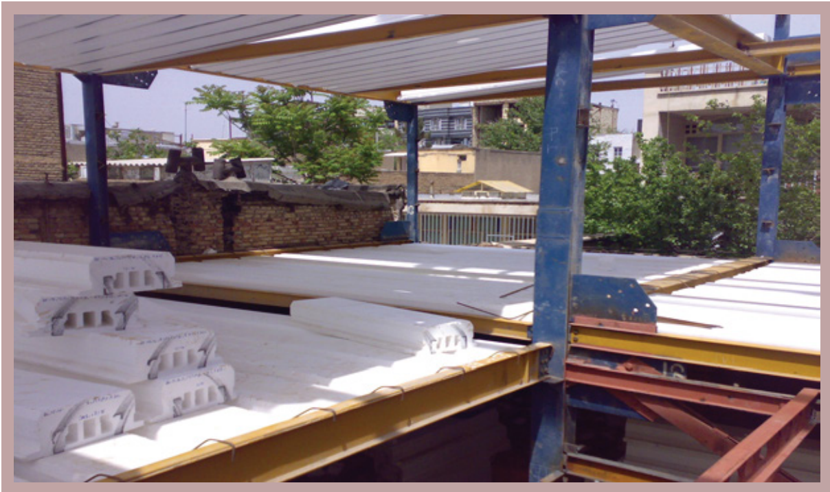
اجرای پانل سقفی سوپر پانل در سازه فلزی
