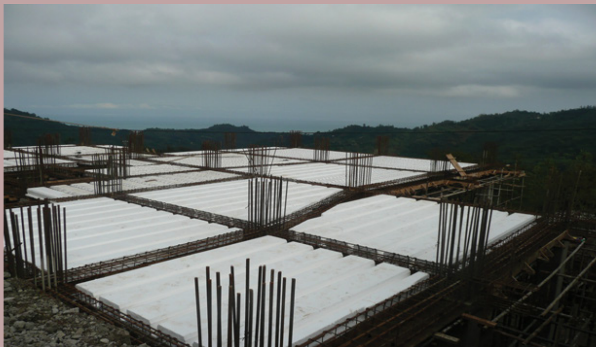
نحوه اجرای بلوک های سقفی
