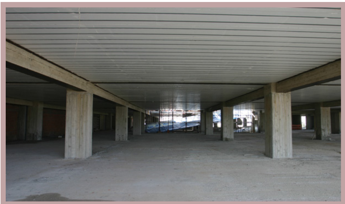
اجرای پانل سقفی سوپر پانل در سازه بتنی
