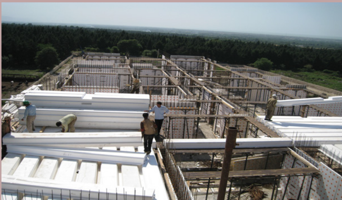
نحوه اجرای بلوک های سقفی
