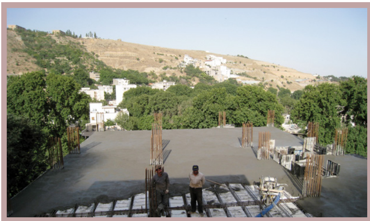
نحوه بتن ریزی سقفها
