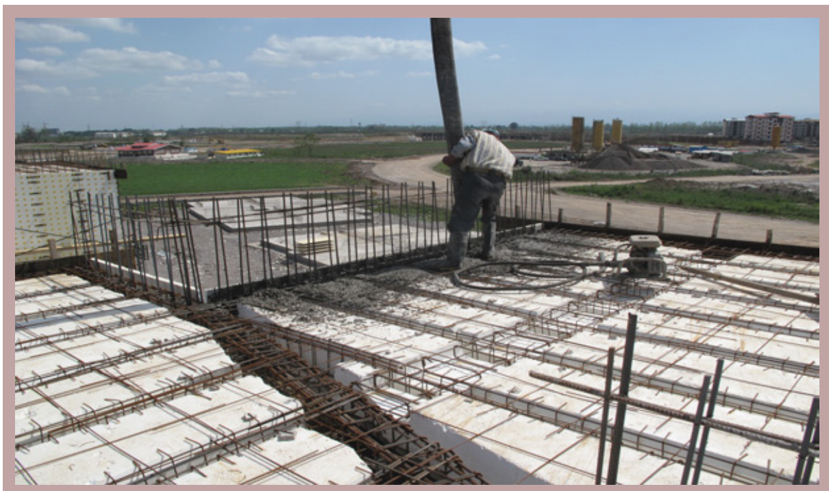
بتن ریزی دیوارها
