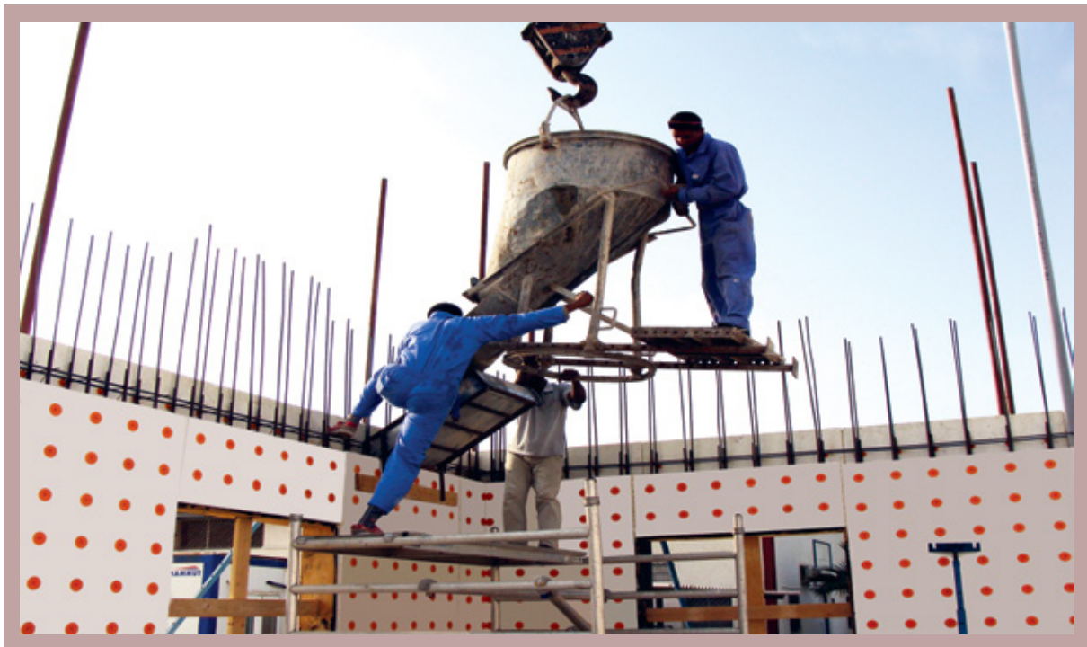
بتن ریزی دیوارها
