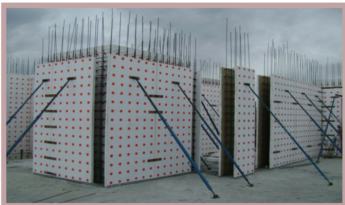
نصب دیوارهای باربر
