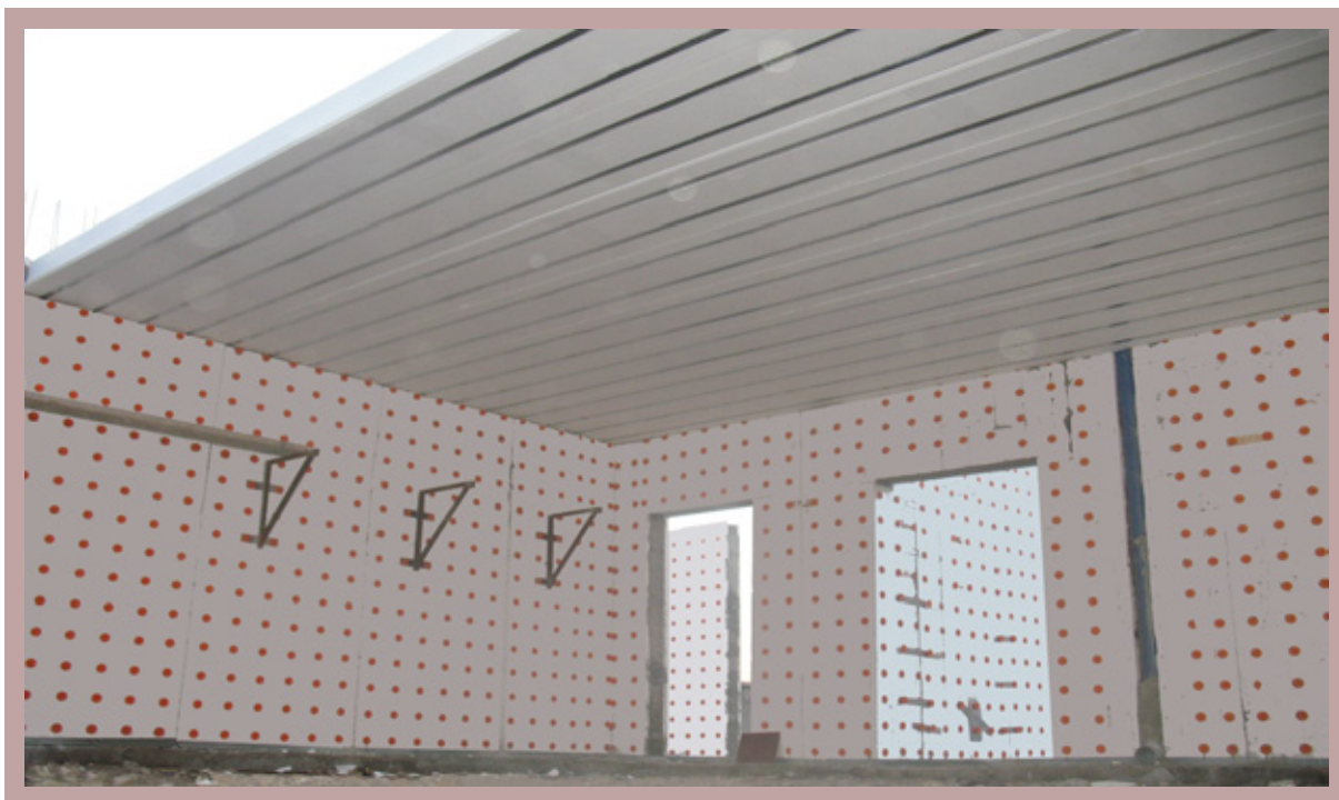
نصب دیوارهای باربر
