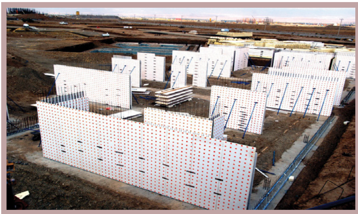
نصب دیوارهای باربر
