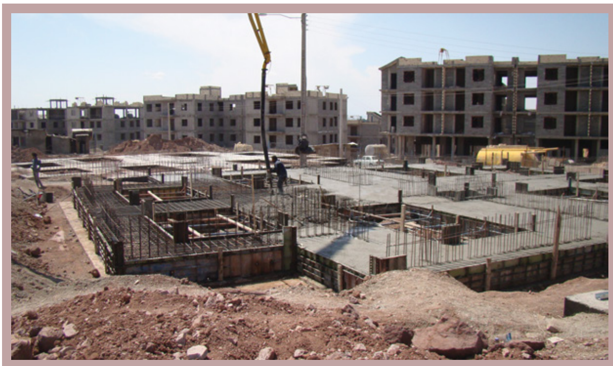
بتن ریزی فونداسیون
