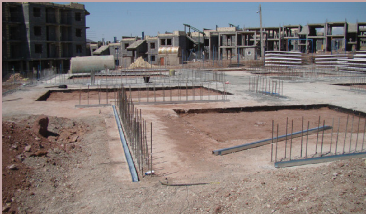
نصب ناودانی ها جهت استقرار دیوار باربر
