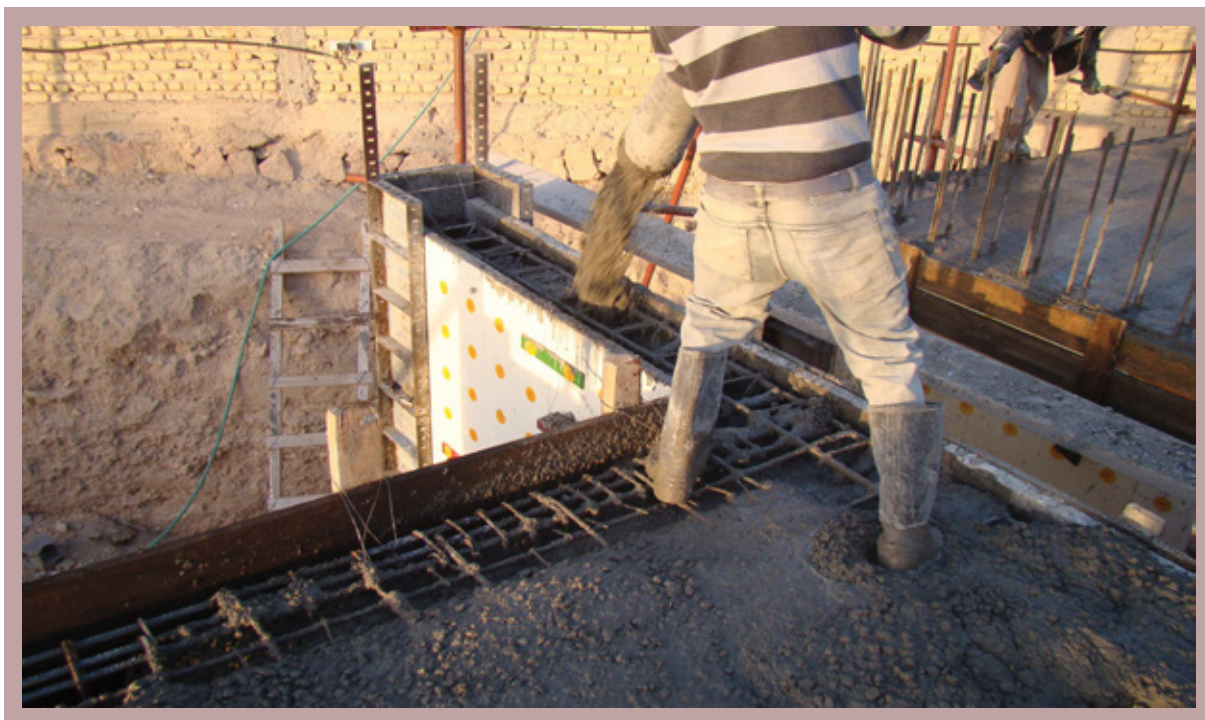
بتن ریزی دیوارها
