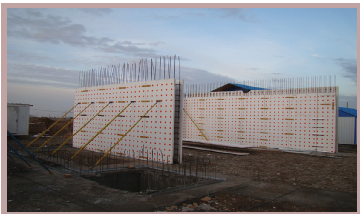
نصب دیوارهای باربر
